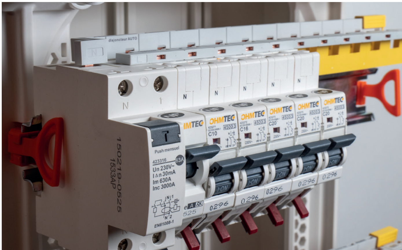
Illustration de montage de la barre de pontage universelle L et N sur disjoncteurs automatiques
